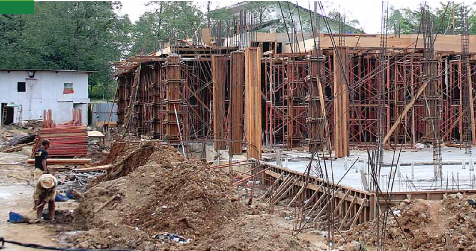
Proses pembangunan masjid Al Madinah kini memasuki proses pembangunan lantai 2. (Foto: Dok.DD/uyang)
